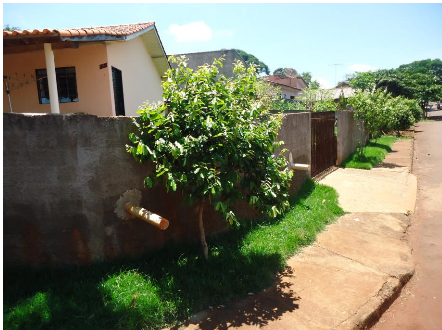
Figura 25 – Árvore muito próxima ao muro
